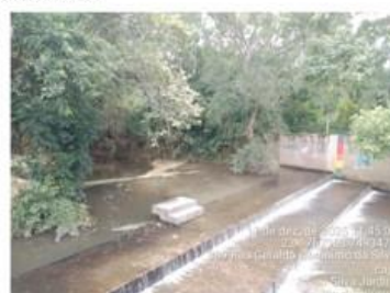
Foto 42: Ecobaceta instalada no Rio Capivari, à jusante do ponto de lançamento, visando a retenção e o recolhimento de resíduos sólidos urbanos (lixo flutuante).
